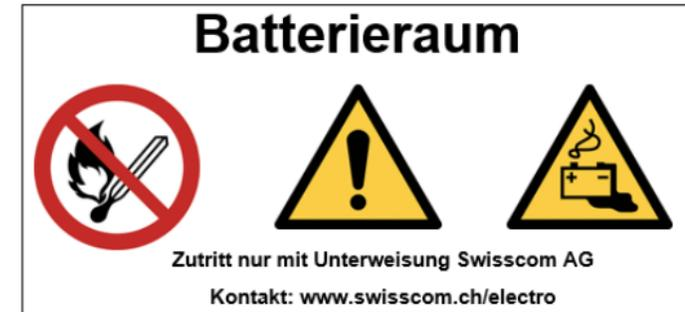
Bild 2.2.3.1: Beschriftung Batterieraum mit Batteriespannung ≤ 60 V DC
