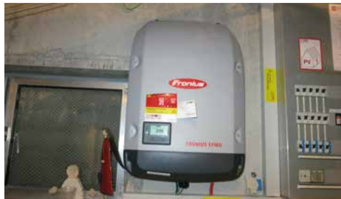
Wechselrichter für die Photovoltaik Anlage (wandelt Gleichstrom in Wechselstrom um).
