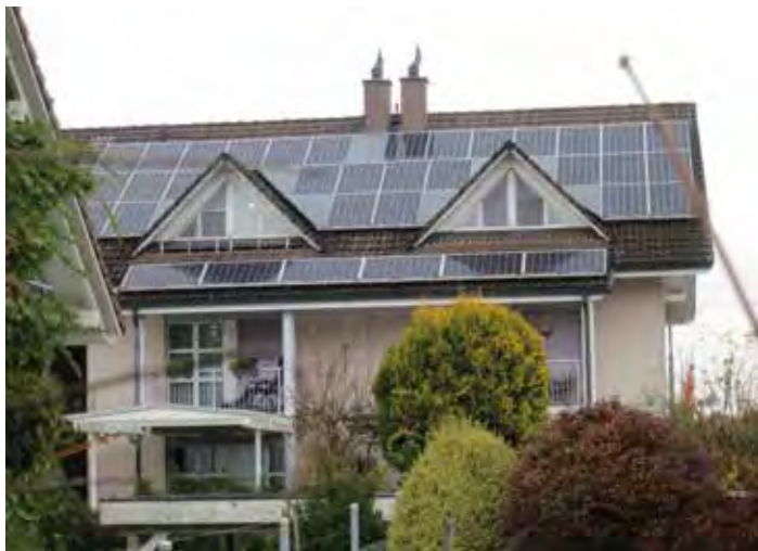
Die Photovoltaik-Anlage des Zweifamilienhauses in Luzern (für die Betreibung der Trinkwasser-Wärmepumpe mit elektrischer Solarenergie genügen in der Regel 3-4 Panel).
