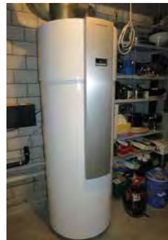
Trinkwasser-Wärmepumpe mit hervorragendem COP von 3,6.
