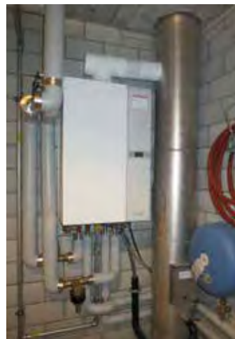
Platzsparende wandhängende Gas-Brennwertanlage als Ausweichoption.
