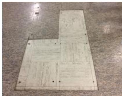
Vinyl-Asbest-Platten sind in den 1950er bis 1970er Jahren sehr häufig verbauter Bodenbelag. Sehr schwer von Linoleum oder PVC-Bodenbelag zu unterscheiden.
