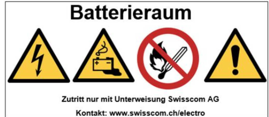
Bild 2.2.3.2: Beschriftung Batterieraum mit Batteriespannung > 60 V DC
