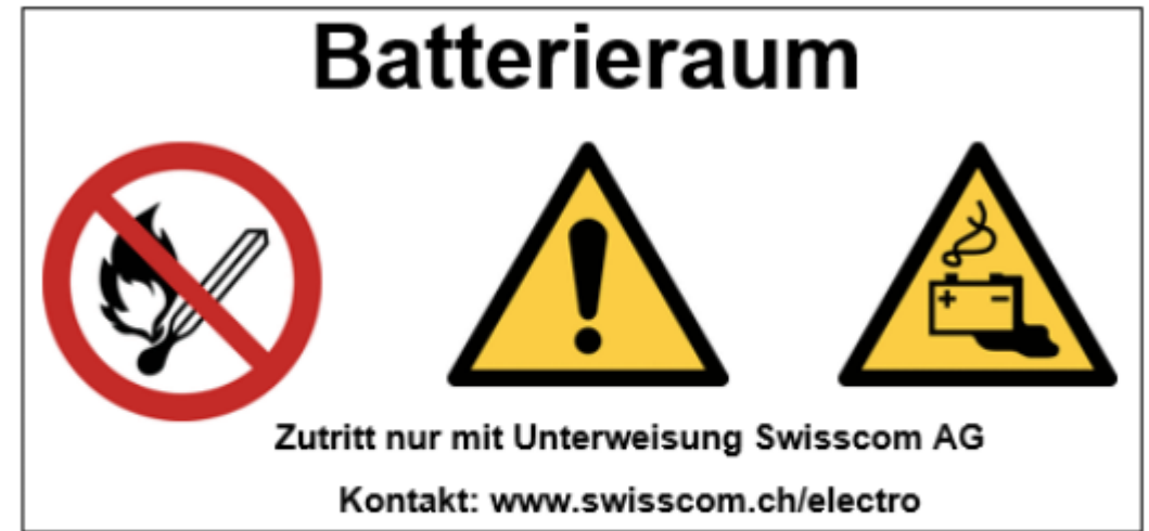
Bild 2.2.3.1: Beschriftung Batterieraum mit Batteriespannung \leq 60 V DC
