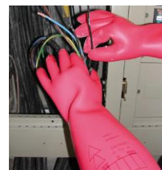
Bild A3.3.2b.7: Isolierhandschuhe Schutzklasse 00 (500V) Schutzklasse 0 (1000V) Schutzklasse 1 (7500V) Schutzklasse 2 (17000V) Schutzklasse 3 (26500V)
