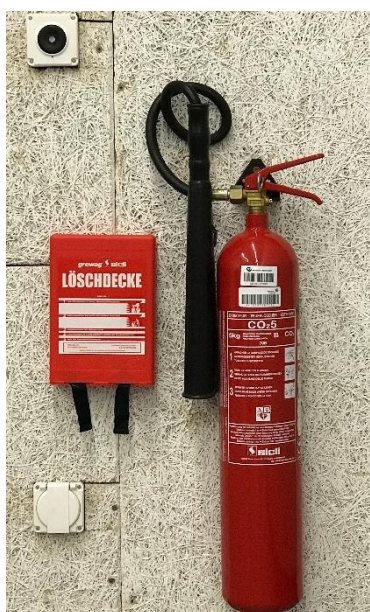
Bild A2.8.6.2: Beispiel CO 2 Löschgerät
