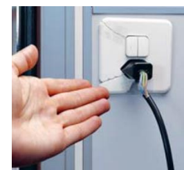
Bild R4.1.7.5: Beispiel defekte Abdeckung und Stecker
