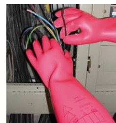
Bild A3.3.2.2c7: Isolierhandschuhe Schutzklasse 00 (500V) Schutzklasse 0 (1000V) Schutzklasse 1 (7500V) Schutzklasse 2 (17000V) Schutzklasse 3 (26500V)
