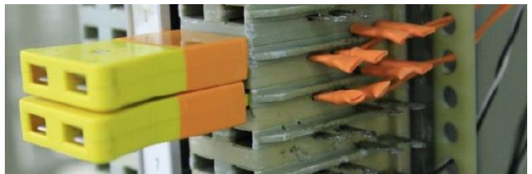
Bild R4.1.6b1: Lötflächen mit orangen Schrumpfschlauch
