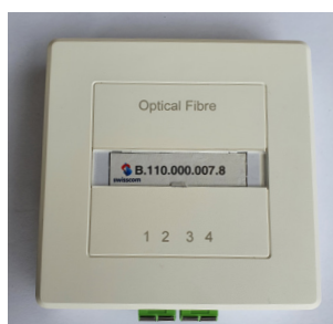
Abbildung 12: Beispiel OTO beschriftet mit der OTO-ID
