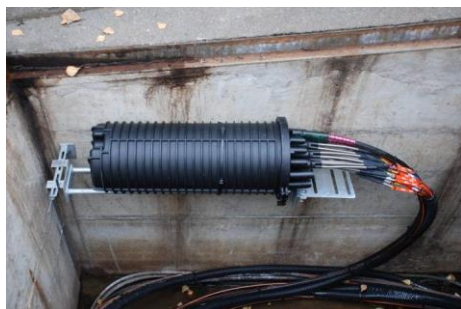
Abbildung 18: Verlegung Spleissmuffe
