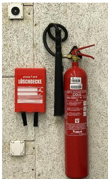
Figure A2.8.6.2: Exemple d'extincteur au CO 2
