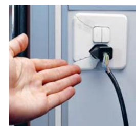
Figure R4.1.7.5: Exemple de barrière et de fiche défectueuses
