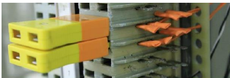
Figure R4.1.6b1: Lames à braser avec gaine thermorétractable orange
