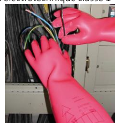
Figure A3.3.2.2b7 : Gants isolants Classe de protection 00 (500 V) Classe de protection 0 (1 000 V) Classe de protection 1 (7 500V) Classe de protection 2 (17 000 V) Classe de protection 3 (26 500V)
