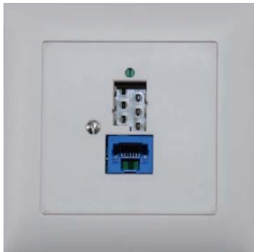
Prises Internet à large bande (DSL) RJ45 et TT83 pour raccordement téléphonique analogique
