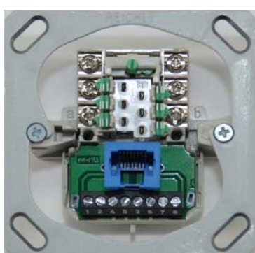
Prises Internet à large bande (DSL) RJ45 et TT83 pour raccordement téléphonique analogique
