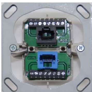
Prises Internet à large bande (DSL) RJ45 et RJ45 ( avec réduction RJ11) pour raccordement téléphonique analogique
