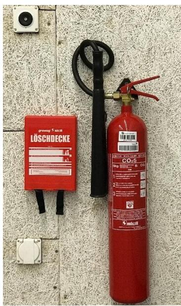
Figura A2.8.6.2: Esempio di estintore a CO<sub>2</sub>
