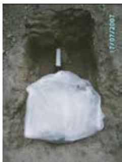
Figura 3: Cavo posato nel terreno all'interno di un sacco di protezione cavi
