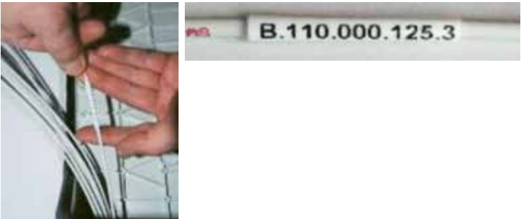
Figura 26: Etichettatura del cavo in fibra ottica in-house con ID OTO e ID Flat
