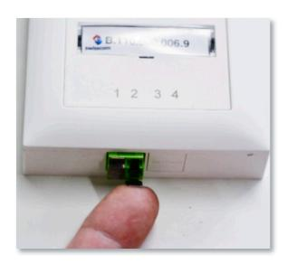
Consigliamo di non toccare la presa, di ricoprirla accuratamente e di ripiegare correttamente la protezione antipolvere color argento.
