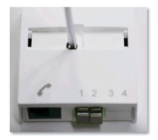
Nel caso di una simile presa è possibile rimuovere la copertura fino al telaio. Rimuovere innanzitutto il n. ID della presa servendosi di un cacciavite. Questo numero deve essere assolutamente conservato. Attenzione: l'ID OTO è unica per ogni abitazione e non può essere scambiata con un'altra. Svitare le viti e rimuovere il copripresa. È necessario ripiegare la protezione antipolvere color argento.
